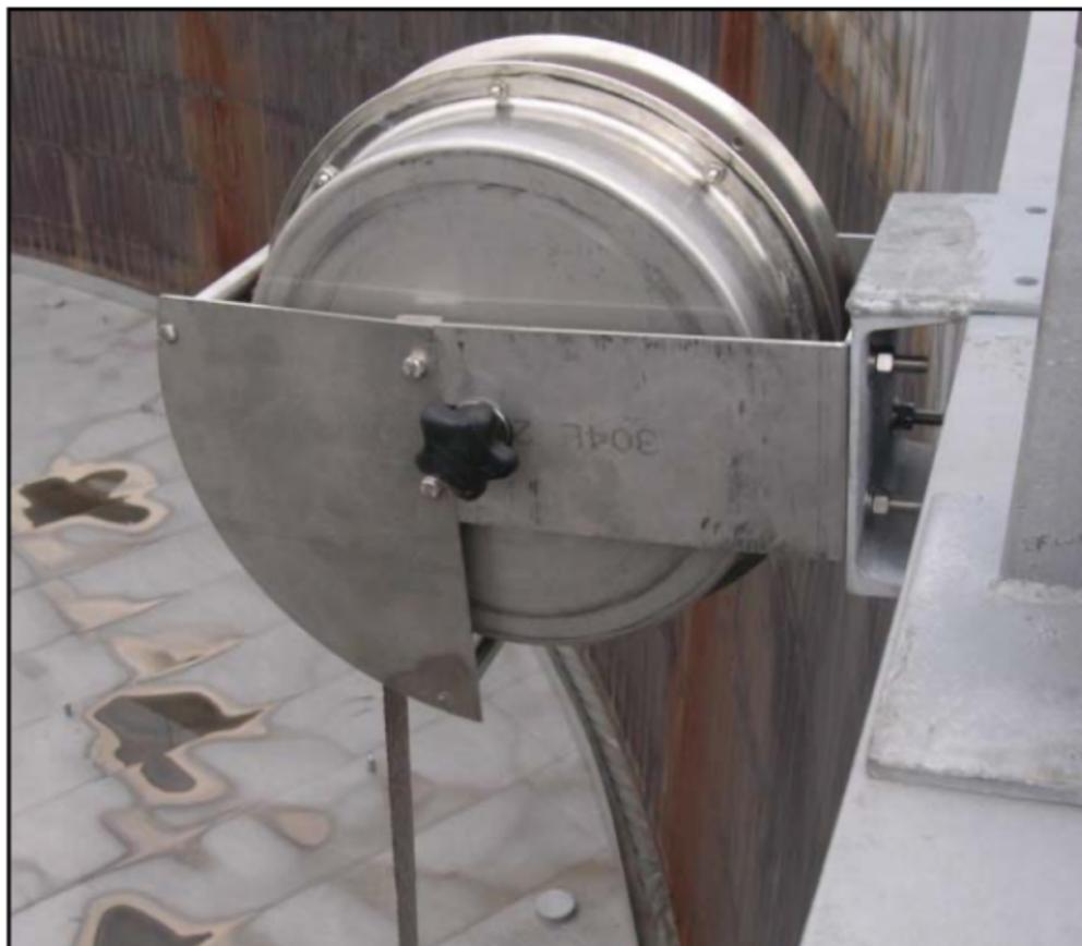
O 'Conjunto de Aterramento Retrátil' LEC RGA™ além de um produto premiado, é um sistema único no mundo, extremamente eficiente de aterramento sem manutenção especialmente projetado para proteção de tanques de topo flutuante.
